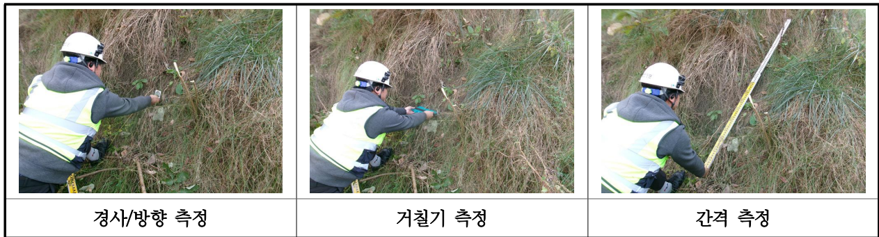
【사진 25.3.4】 불연속면 측정 현황
